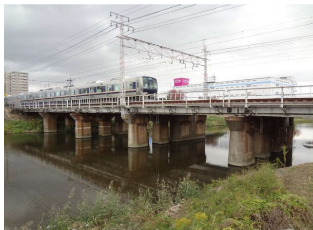
市内 芥川に架かる鉄道橋梁
