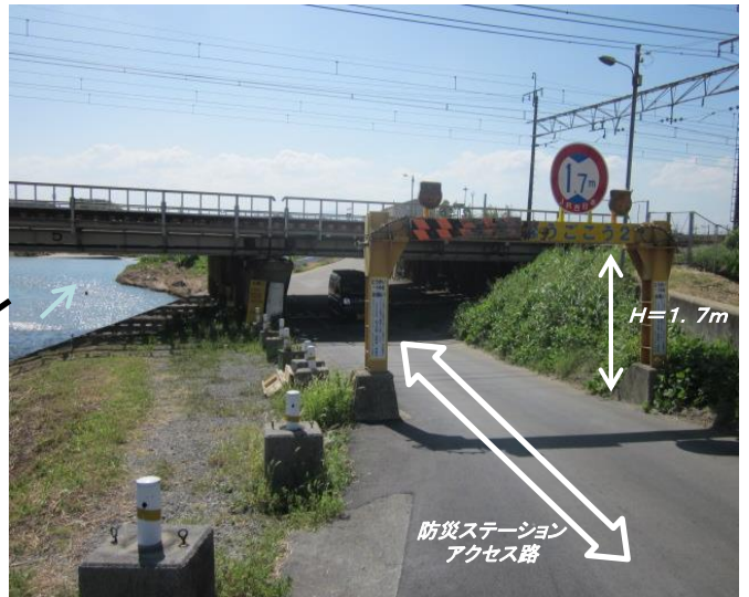
JR橋梁 未改修区間(JR桁下H=1.7m)
